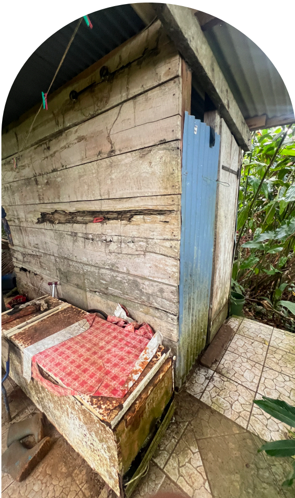
extérieur cabane avant rénovation
